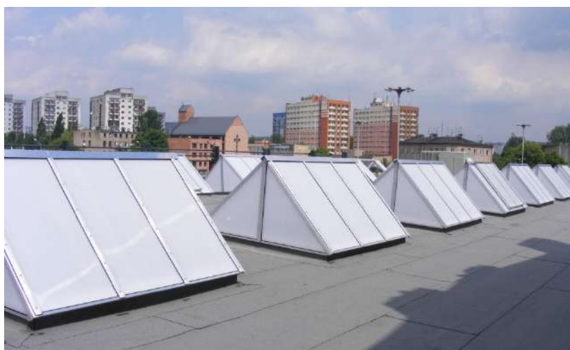
Зенитные ленточные фонари с треугольным сводом, со встроенными люками дымоудаления
