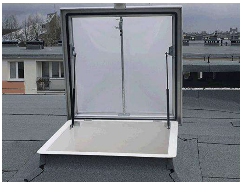
Люк для выхода на кровлю
