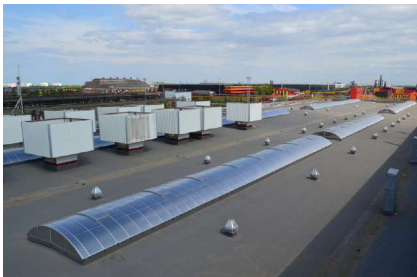
Зенитные ленточные фонари с арочным сводом, со встроенными люками для вентиляции
