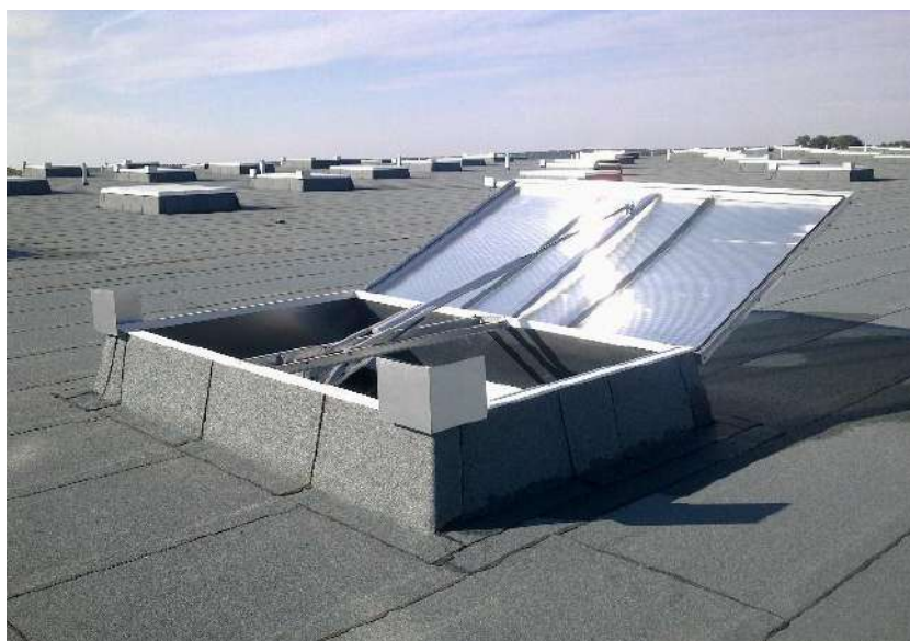
Люки дымоудаления со светопропускающим заполнением из поликарбоната
