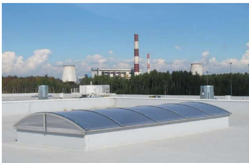
Зенитный ленточный фонарь с арочным сводом
