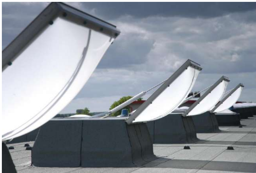
Люки дымоудаления со светопропускающим заполнением из акрила
